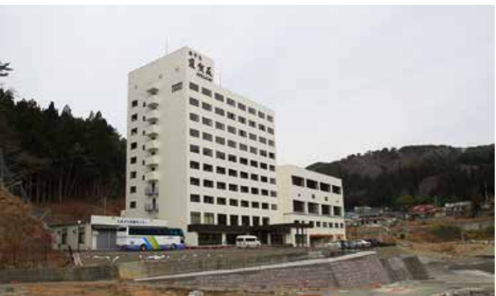
観光施設修繕工事が行われるホテル羅賀荘
