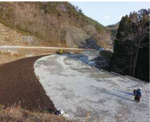
改良工事が進む羅賀地区の村道田野畑平井賀線
