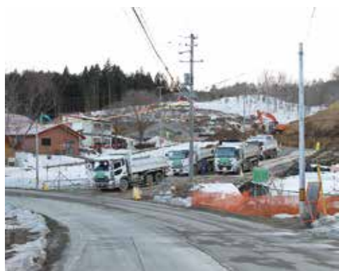
工事現場からの出入り口は泥で滑るので注意
