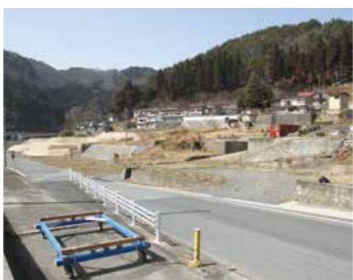
27年度から防潮堤の工事が始まる平井賀地区
