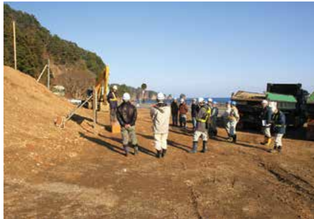
12月17日、東北地方整備局三陸国道事務所による三陸沿岸道路・尾肝要普代道路の土砂提供説明会。写真左上の赤い印まで土地がかさ上げされます
