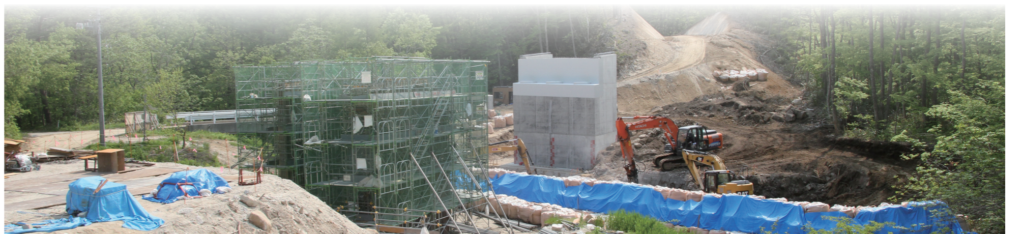
工事が進む村道長嶺線（一ノ渡の明神橋付近、5月20日撮影）
