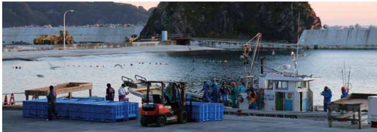
本設魚市場の建設中は島越漁港南港で水揚げが行われた
