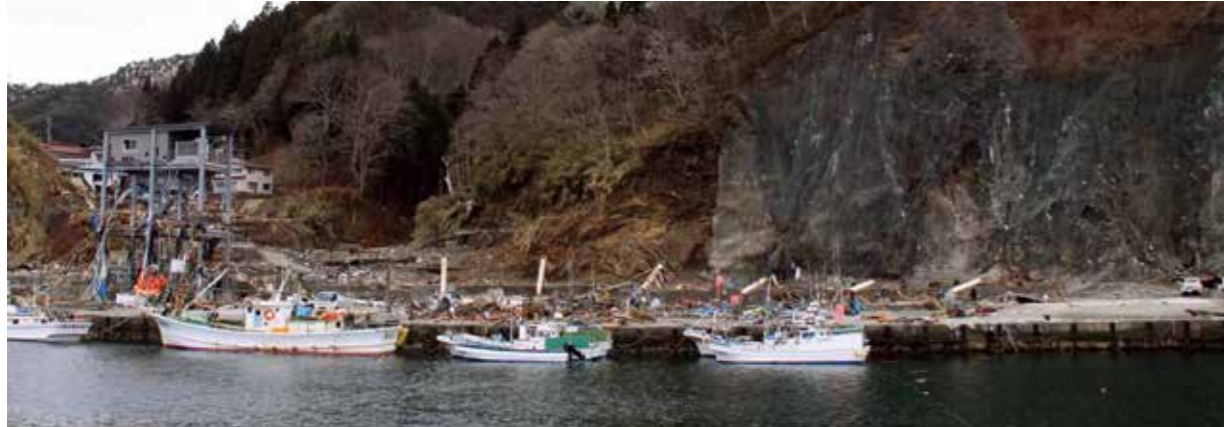
製氷施設の骨組みと市場の一部鉄骨を残し流出
