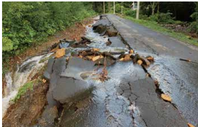
村道沼袋三沢線では9カ所で路肩が崩壊
