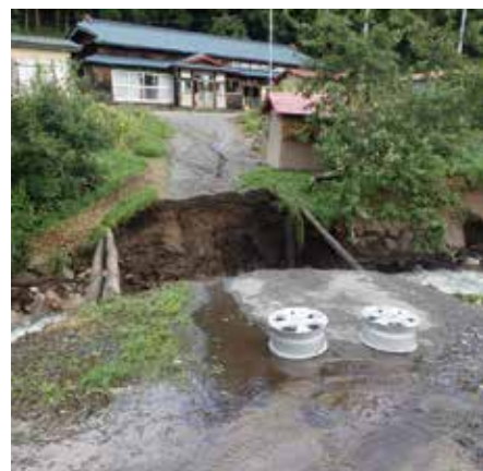
川の水かさが増し、村道から住宅への橋が流出。被害件数は7件にのぼる
