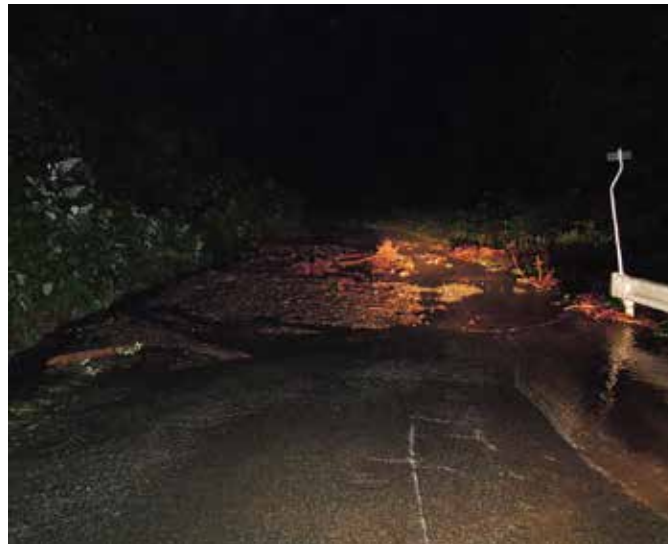
山からの土砂でふさがれた村道鉄山線
