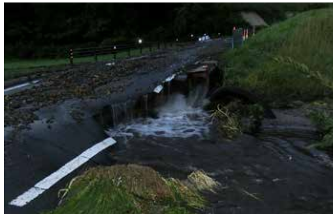
村道沼袋田代線では小さな沢が氾濫し道路が崩壊
