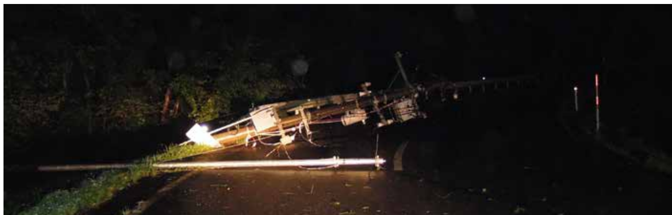
村道鉄山線では倒れた電柱が道路をふさぐ
