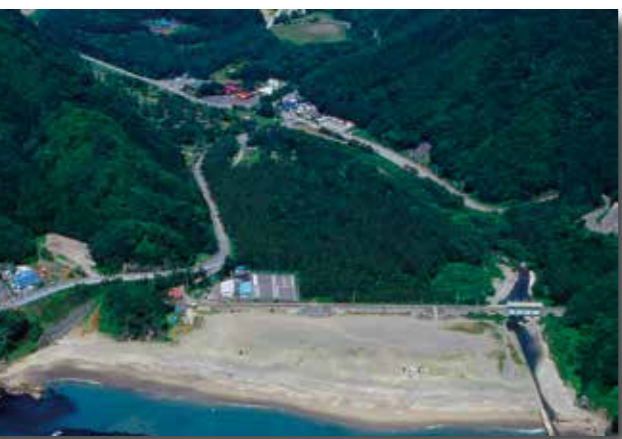
震災前の明戸海岸防潮堤
