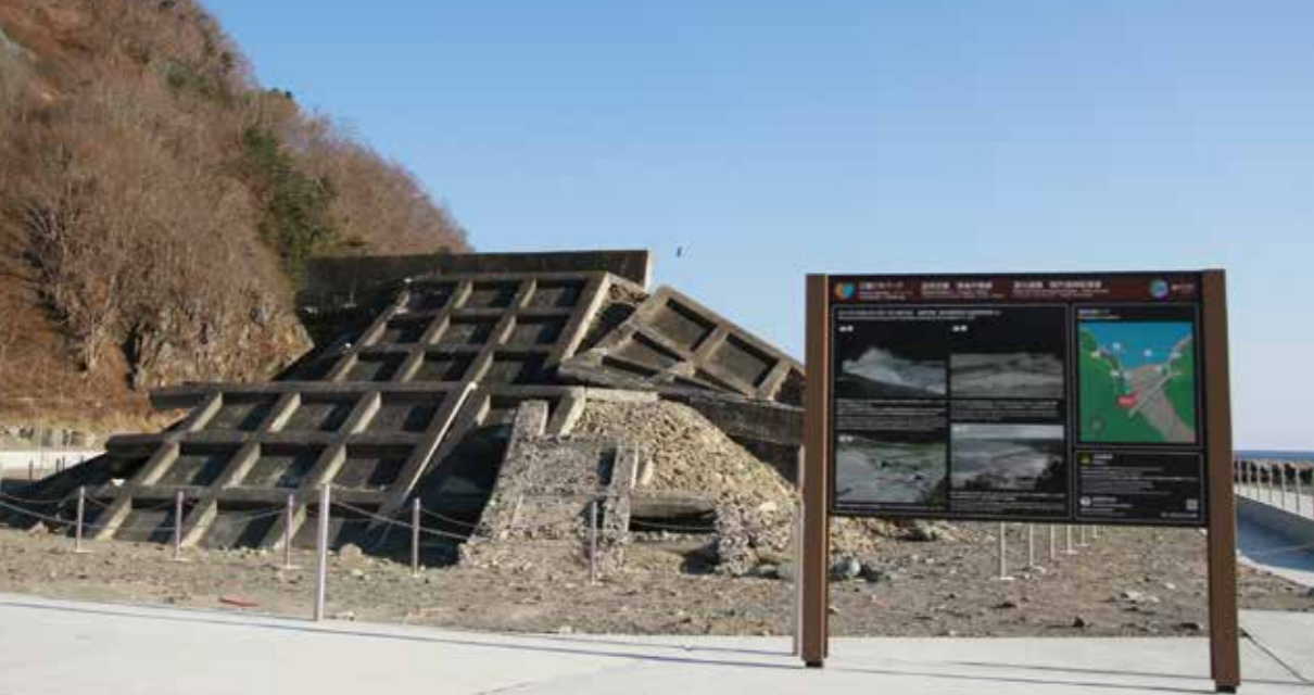
完成した震災遺構 明戸海岸防潮堤。被災当時の姿をそのままに、震災の記憶を後世に伝える
