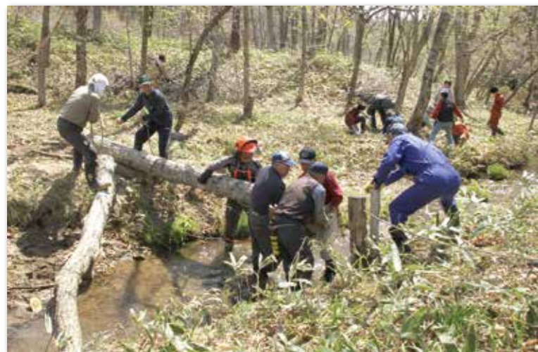
橋の復旧作業を行う皆さん
