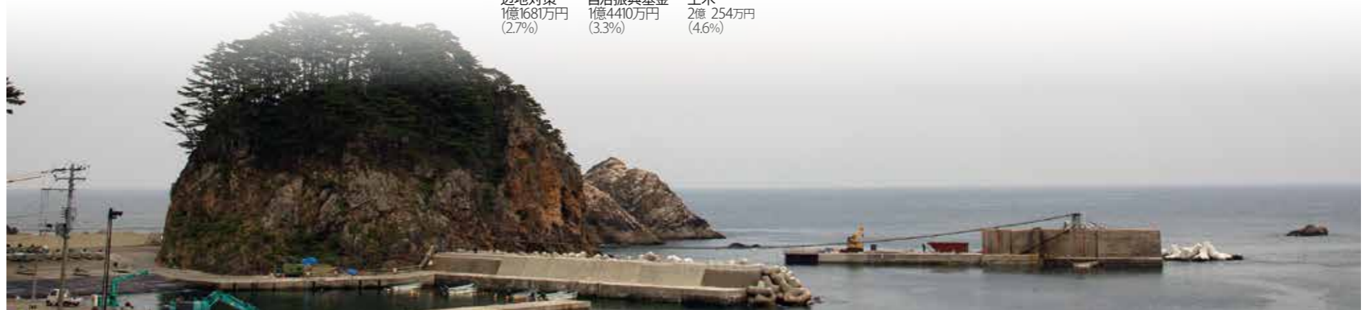
本年度末の完成に向け、工事が進む机漁港沖防波堤（5月22日撮影）
