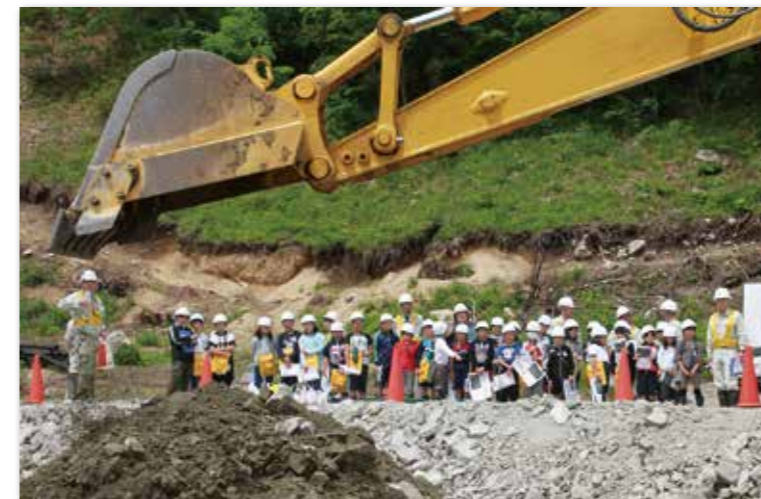
重機の作業風景を見学する児童たち
