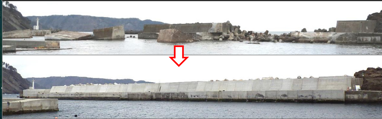
東防波堤先端部 復旧状況 (H29. 3. 17完成)
