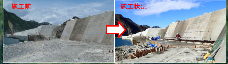
東防波堤 通路部嵩上げの施工状況 (H30. 2. 6現在)
