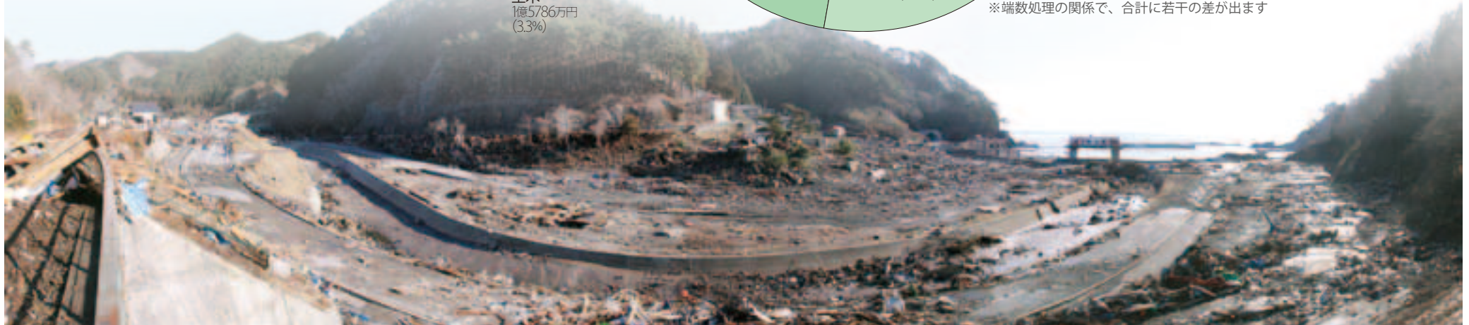
東日本大震災で大きな被害を受けた村沿岸部。懸命の復旧作業が毎日行われている(平井賀地区パノラマ合成写真・3月12日撮影)
