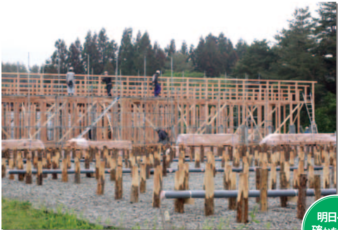
6月末の完成目指し、急ピッチで建設が進むアズビィ施設の仮設住宅
