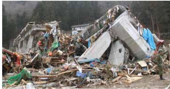
大津波で橋脚が破壊され線路も寸断された（3月13日、島越駅周辺）
