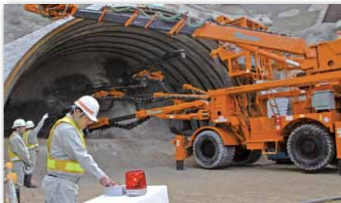
尾肝要トンネルの掘削作業が始まった
