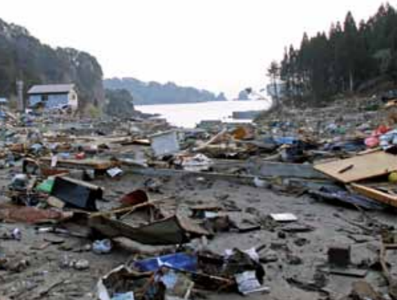
津波翌朝の羅賀地区。廣内さんの自宅や倉庫など多くの建物が流出。写真左に残る防災センターの1階は鉄骨の骨組みだけが残った
