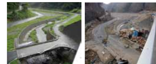
がれき撤去が終わり、今後は復旧工事を実施
