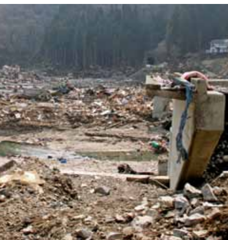
震災直後の島越駅周辺の様子
