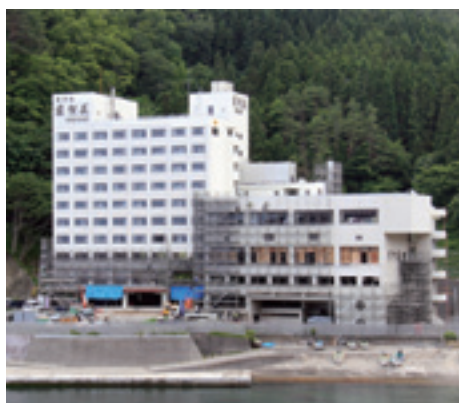
営業再開に向け工事が進むホテル羅賀荘
