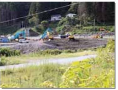
9月 三陸鉄道の全線運行再開に向け、島越地区で本格的な復旧工事を開始
