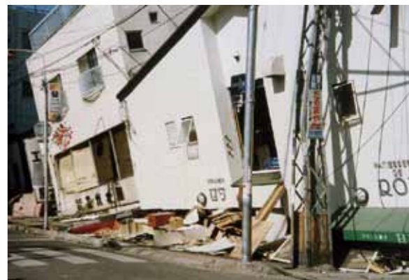
阪神淡路大震災で1階がつぶれて倒壊した建物 (出典・消防科学総合センター)
