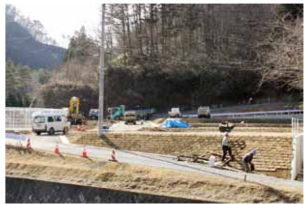
仕上げ作業が進む松前沢の住宅移転用地造成 8月上旬には災害公営住宅を完成させる予定
