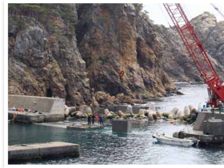
← 机漁港 倒壊した防波堤を復旧するため、7月末の完成を目指しブロックの据え付け作業を進めている机漁港。今後は沖防波堤の復旧も始め、机漁港全体では本年度中の完成を目指している。
