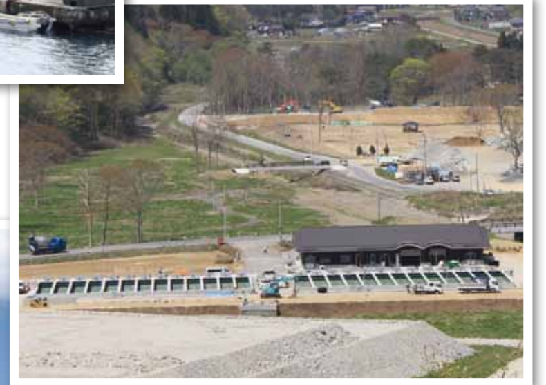
↓ サケふ化場 明戸地区で工事が進むサケふ化場。震災前はキャンプ場だった場所に、今年の秋の稼働を目指して建設中。写真奥ではマレットゴルフ場や村道長内沢線のかさ上げ工事を進めている。
