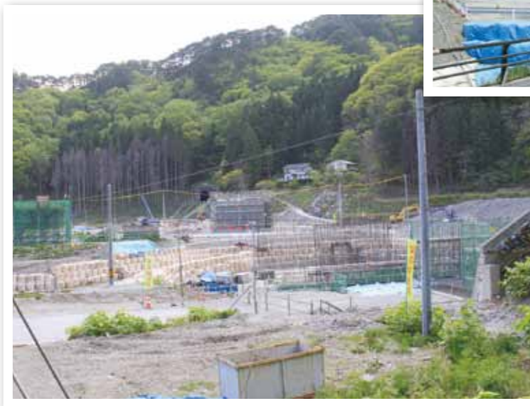
三陸鉄道 昨年9月から本格的な工事が始まった三陸鉄道の田野畑一小本間。島越は高さ9メートル、長さ400メートルの盛り土上に線路を敷設する。ハイペ浜付近（写真㊸）でも工事が順調に進んでいる。
