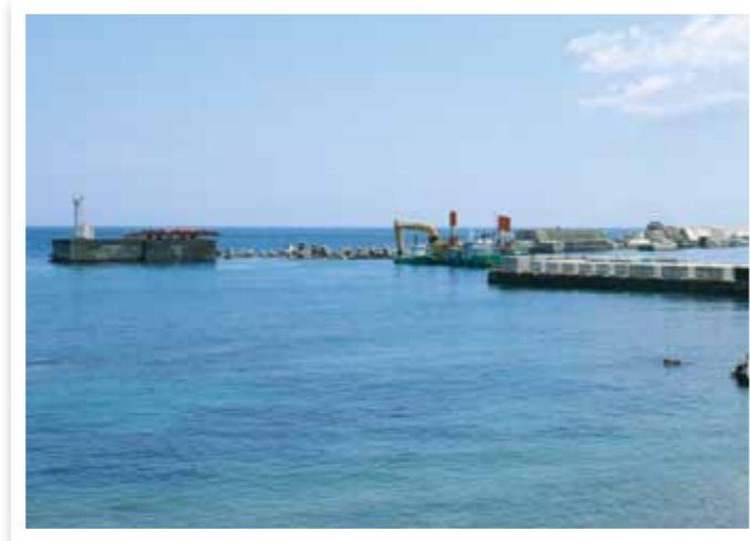
↑ 嶋之越漁港 津波で破壊された防波堤の撤去作業が進む嶋之越漁港。
