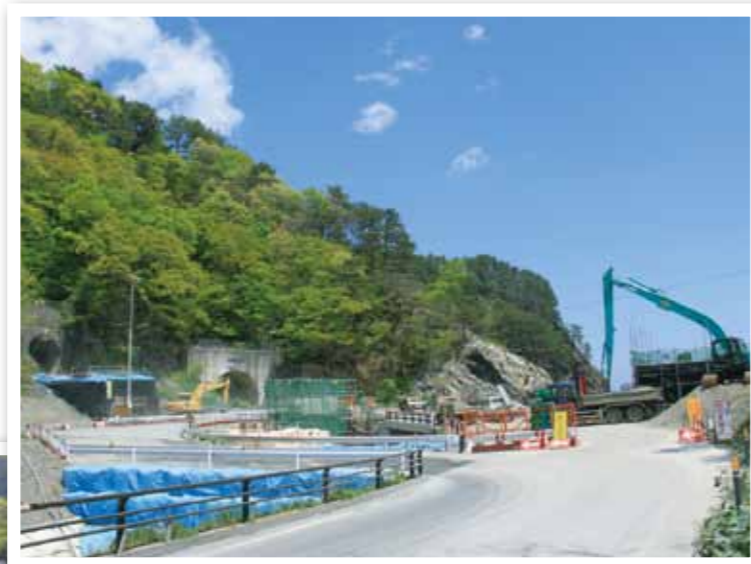
三陸鉄道 昨年9月から本格的な工事が始まった三陸鉄道の田野畑一小本間。島越は高さ9メートル、長さ400メートルの盛り土上に線路を敷設する。ハイペ浜付近（写真㊸）でも工事が順調に進んでいる。
