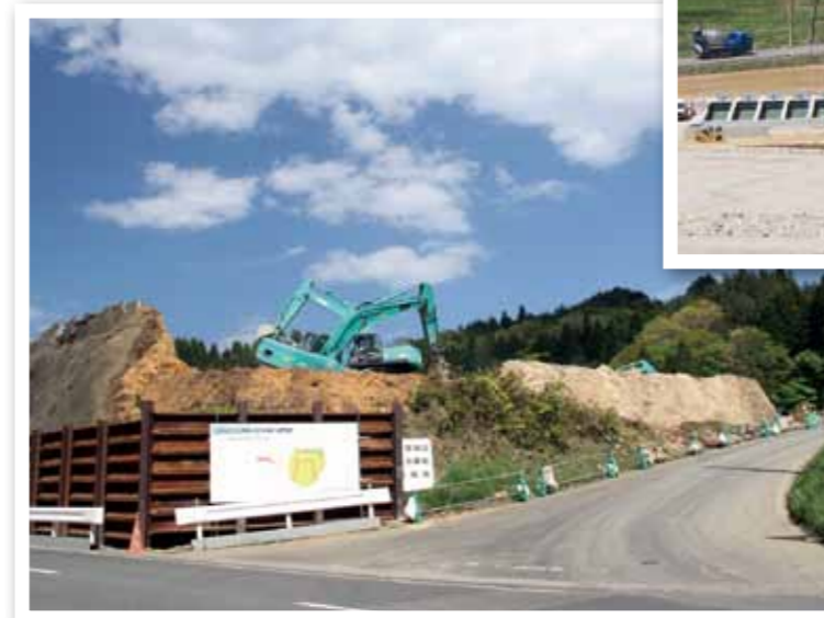
↑ 高台移転団地造成 現在、「黒沢山」「記念林」「白池峠」の3団地で進めている造成工事。9月末の完了を目指して工事を進めている。写真は記念林（羅賀）。山の切り崩し作業が進む。
