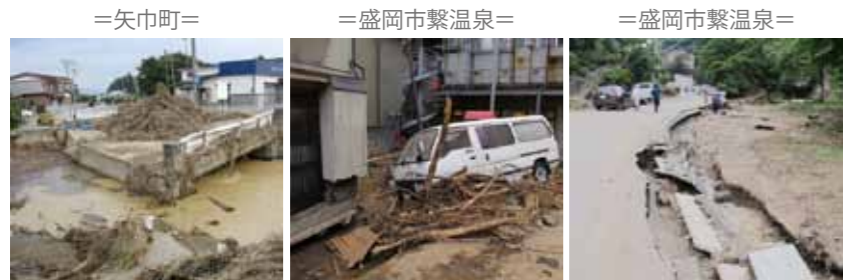
8月9日の大雨で本県内陸部が大きな被害（盛岡地方気象台提供）
