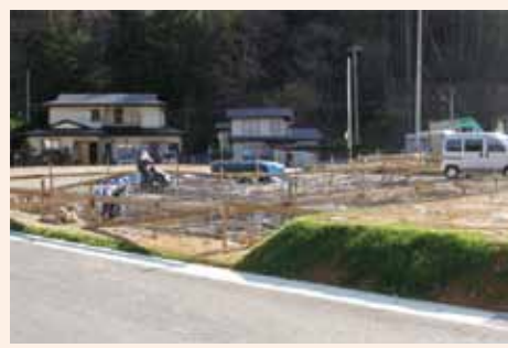
災害公営住宅の建築が進む羅賀東団地
