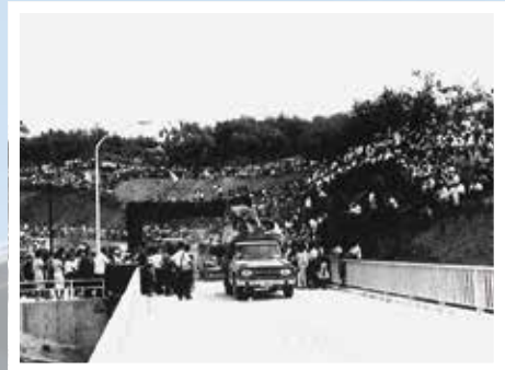
国道45号の榎木沢橋(全長240メートル、高さ105メートル)が開通 (昭和40年)
