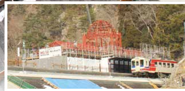
島越駅は6月末の完成を目指して建設中
