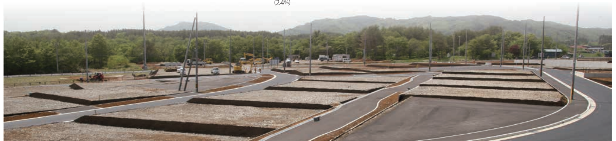
6月末の完成を目指して整備を進めている拓洋台団地（5月23日撮影）
