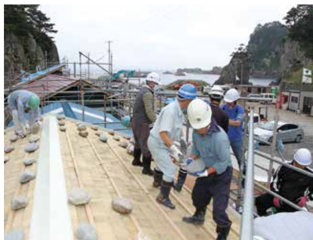
桁屋根(まさやね)に重りの石を等間隔で並べます(右)
