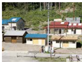
トタン屋根の明り取りなど、流失した番屋を忠実に再現
