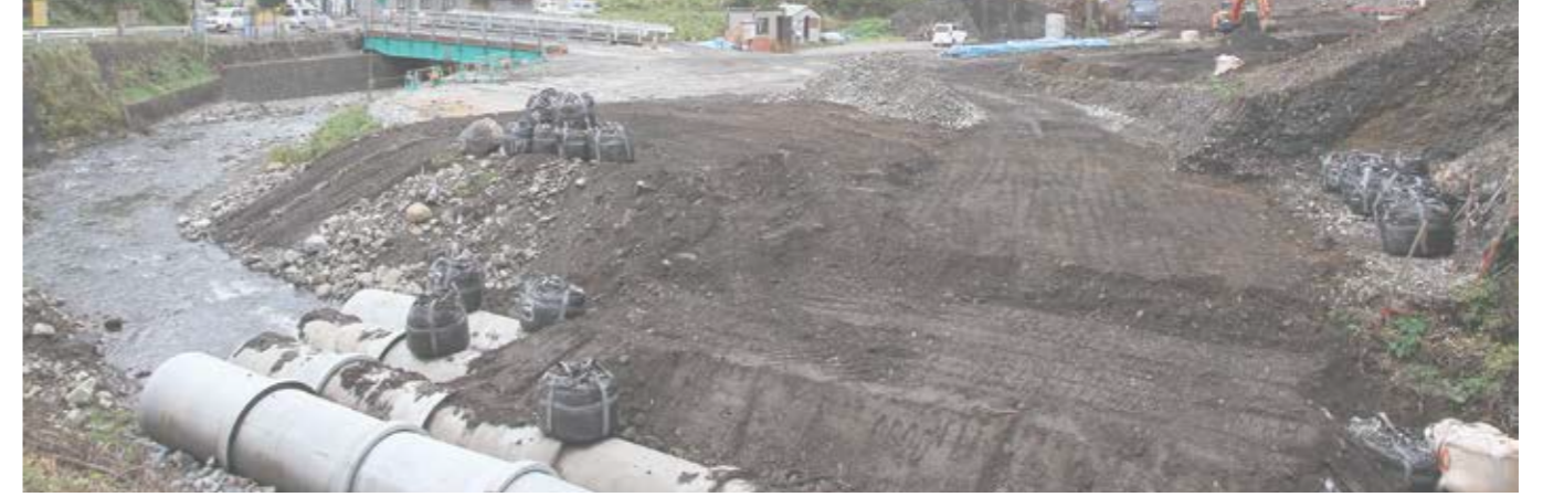
平成27年度の完成を目指し、工事が進む羅賀地区の上川原地区と海鳴台団地をつなぐ村道海鳴台線
