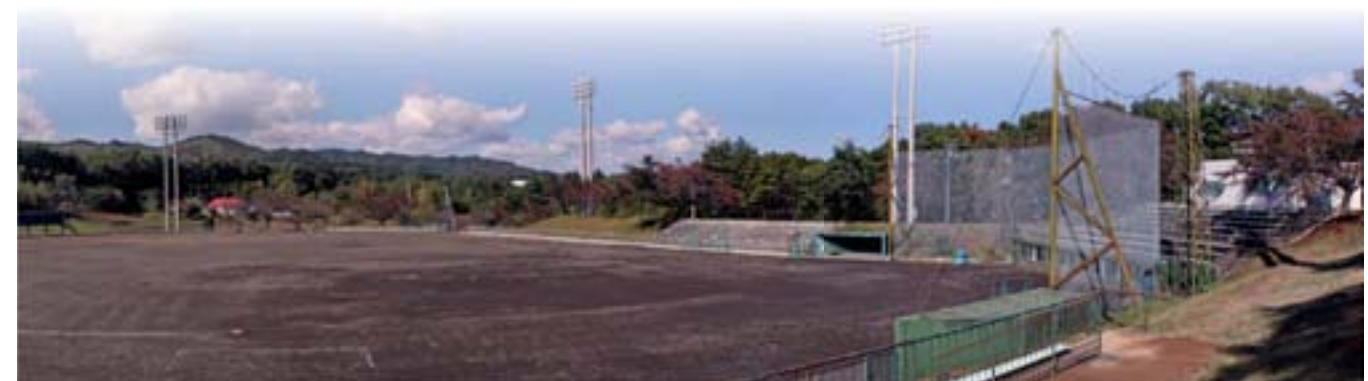
スタンドやダッグアウト、管理棟などを改修し、リニューアルする村営野球場
