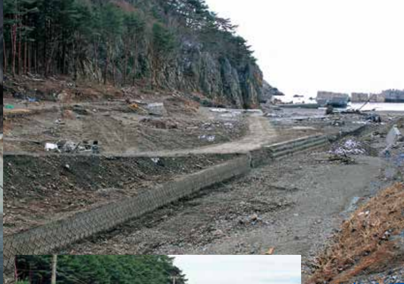
震災後の明戸浜全景
