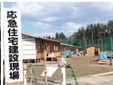
仮設住宅の建設が進む(平成23年7月頃)
