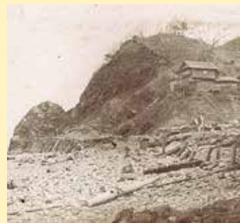
島越・沢村地区(昭和三陸大津波)
