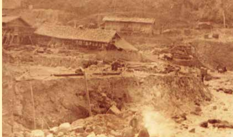
島越・沢村地区(昭和三陸大津波)
