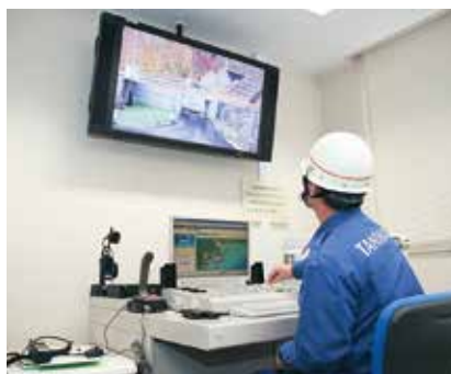
水門遠隔操作
