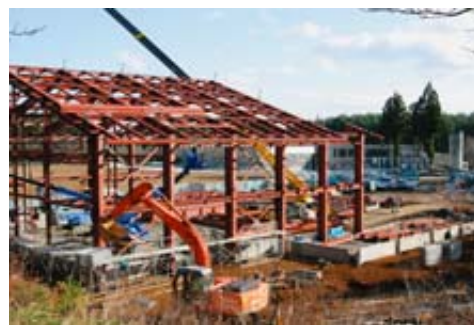
建設中の屋内運動場（12月10日撮影）
