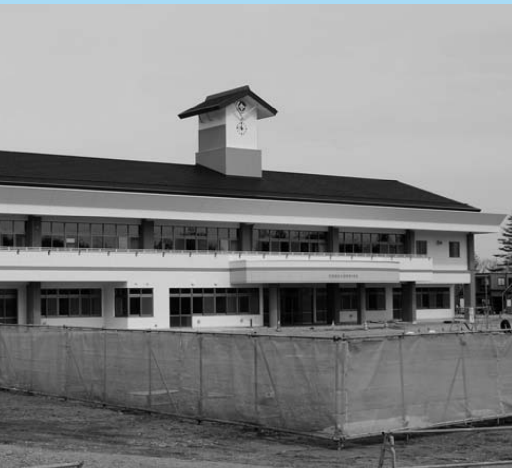
建築が進む中学校校舎。新年度2学期からは新しい校舎での授業が始まる予定
