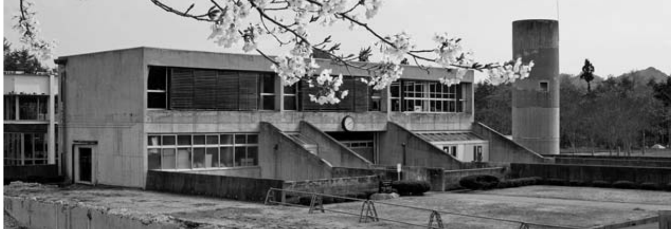
現在の中中学校校舎を解体し、新しいグラウンドが整備されます
