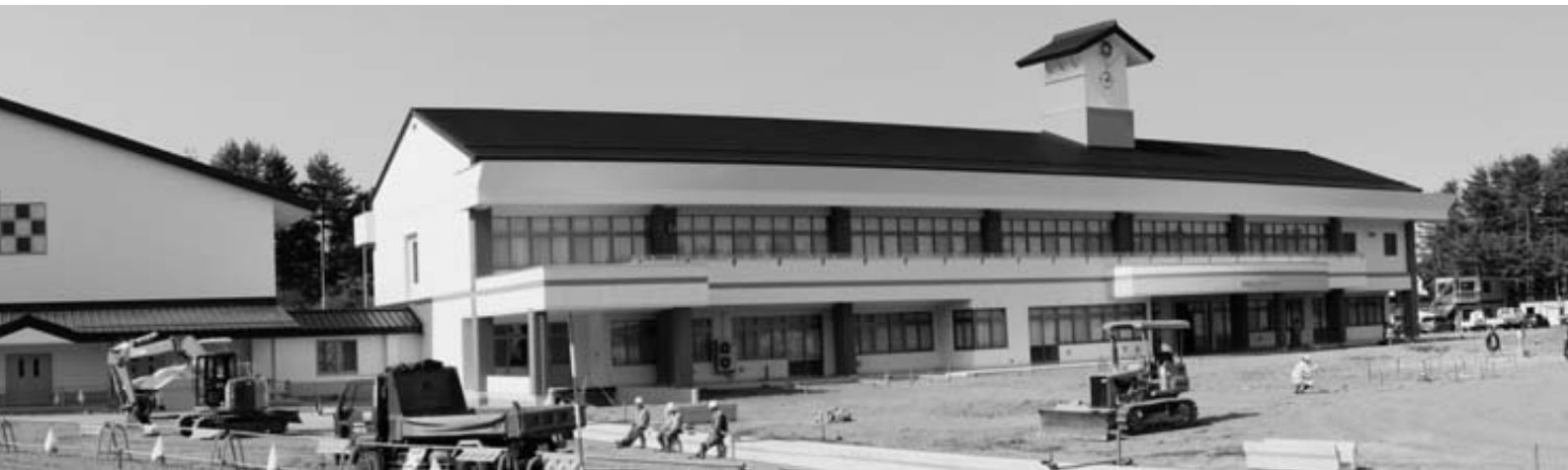
順調に工事が進む中学校。現在は外構工事などが行われています（5月25日撮影）
