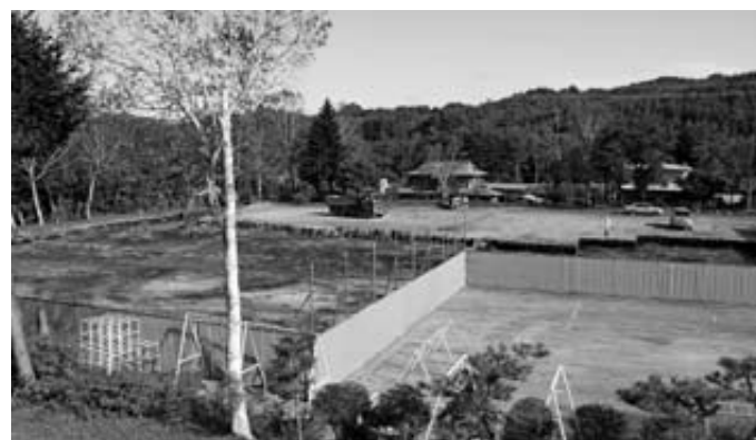
4月開業を目指して工事が始まった沼袋地区の介護老人施設
