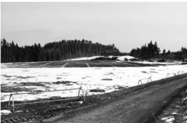
旧校舎を取り壊しグラウンド整備が進む中学校
