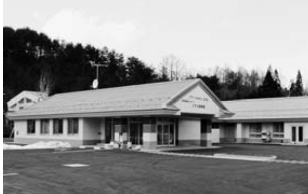
既存の特別養護老人ホームの施設介護サービス提供に加え沼袋地区に建設された施設での入所サービスも始まります
