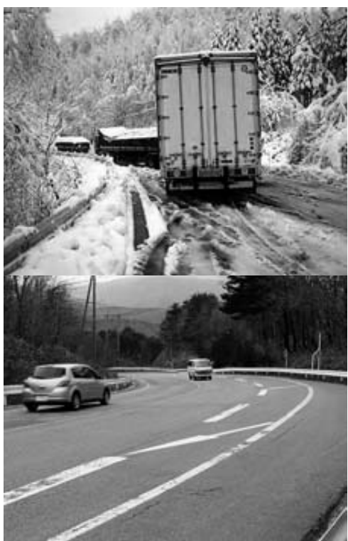
急カーブ急こう配の続く国道45号尾肝要道路1日でも早い完成を目指し関係機関に働き掛けます
