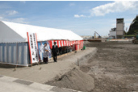
仮設市場などは撤去され着工を待つばかり
