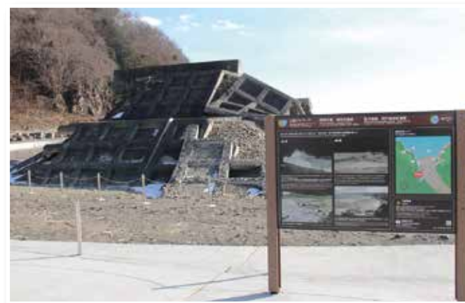
12月12日、震災遺構明戸海岸防潮堤が完成
