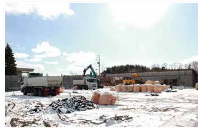
3月23日、村内最後の仮設住宅「アズビィ仮設」解体工事完了(写真:2月28日撮影)
