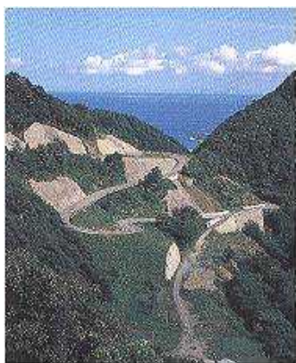
写真 深い谷と道路
