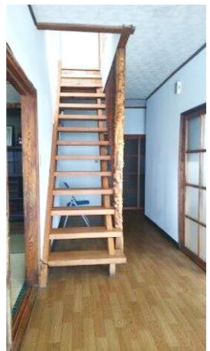
1階 廊下・階段
