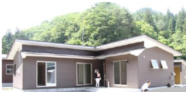
災害公営住宅
