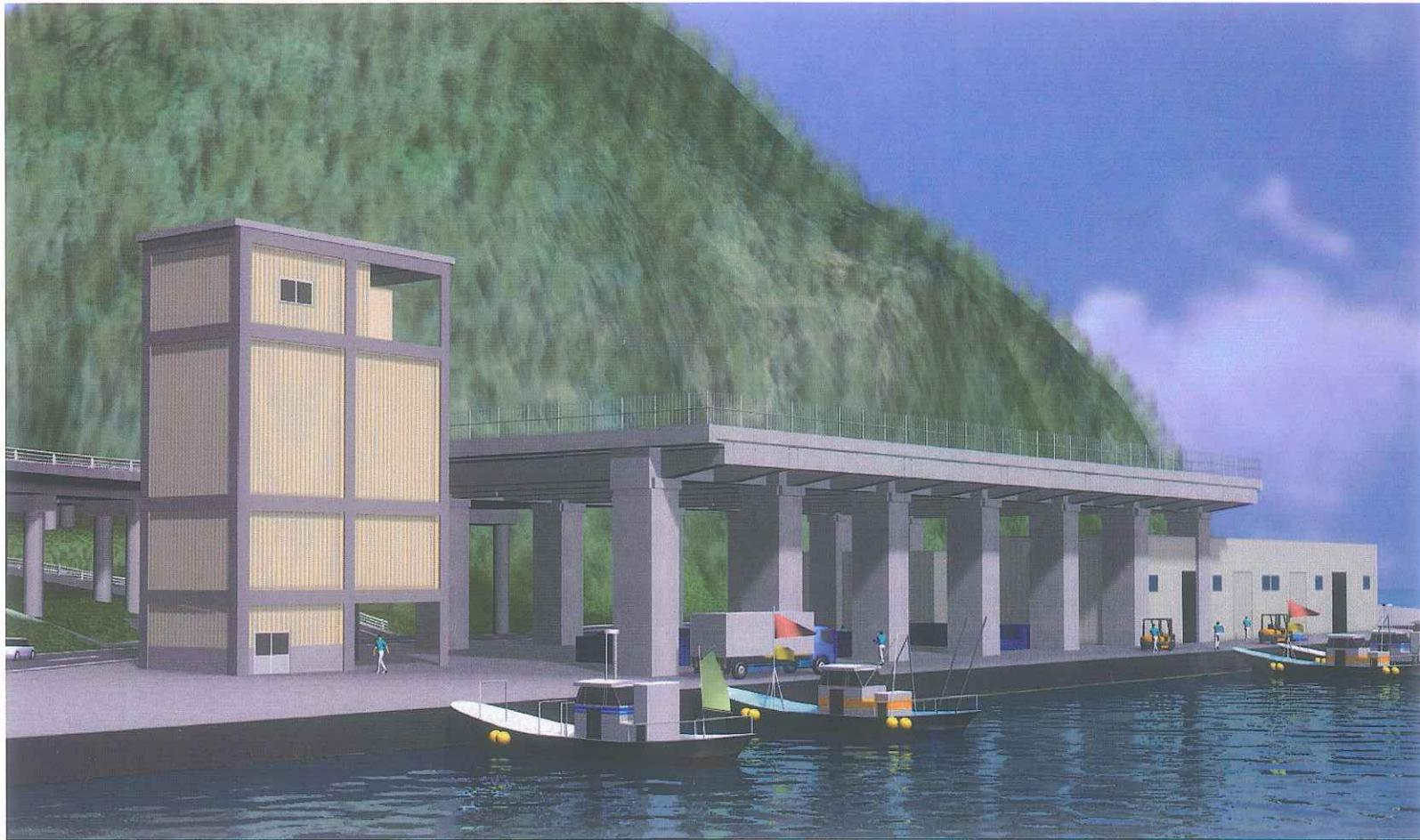
構造 面積：1,041 m<sup>2</sup> (41m×25.4m) 高さ：T.P. +11.0m (地上部分の利用と背後県道との擦り付けから設定)
