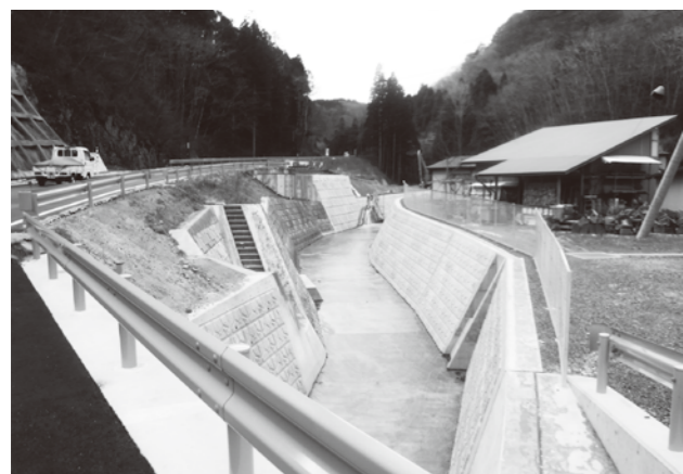
ボックス撤去および護岸整備状況(下流側から撮影)
