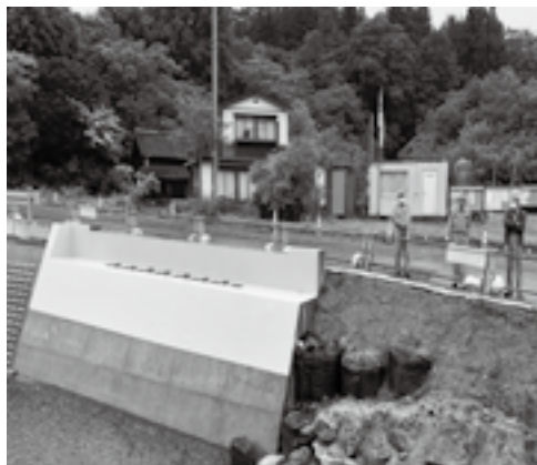
村道沼袋三沢線橋梁下部工の状況
