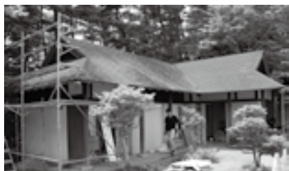
改修中の北山崎園地のトイレ。 8月中旬には完成予定です。
