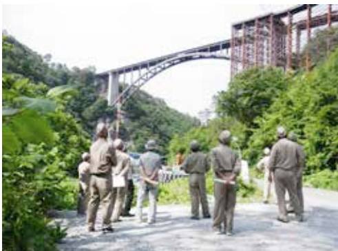
新思惟大橋の工事を見上げるようす
