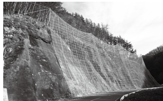
落成対策施工後の状況
