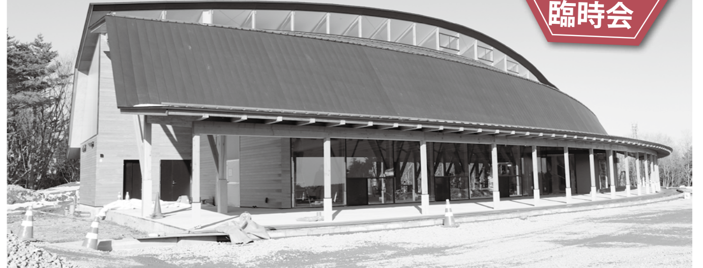
内装や周辺整備中の新道の駅
