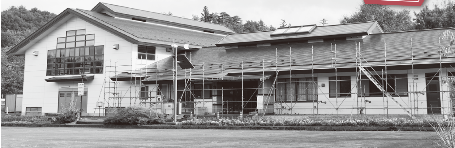
屋根を修繕中の農村環境改善センター
