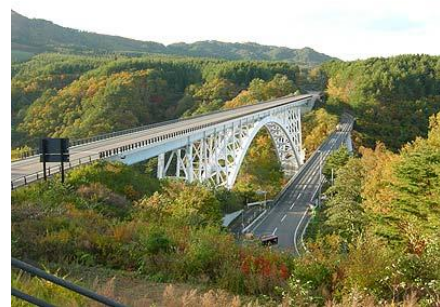
写真 北上山系の深い谷を結ぶ 槇木沢橋（手前）と思案坂大橋（奥）
