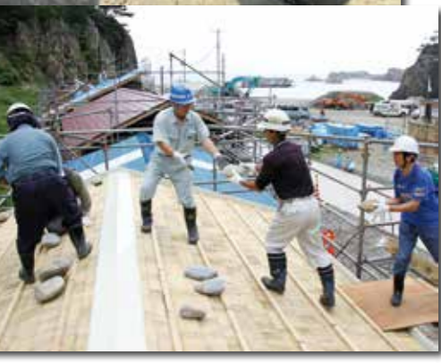
机浜番屋群再生プロジェクトの様子 ④井戸の中にとまった、土砂の取り除く ⑤海岸から運んだ石を屋根に積む
