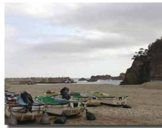
防潮堤工事が終了した机浜の様子
