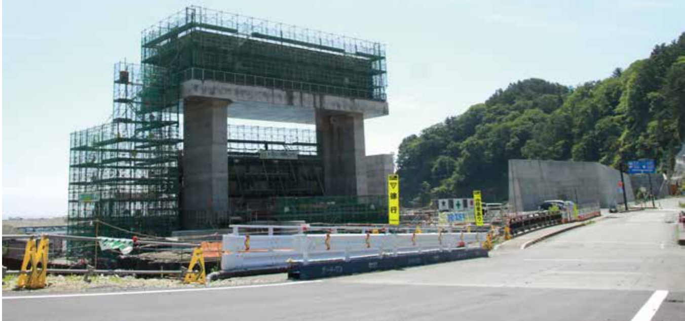
防潮堤災害復旧工事が行われている平井賀漁港
