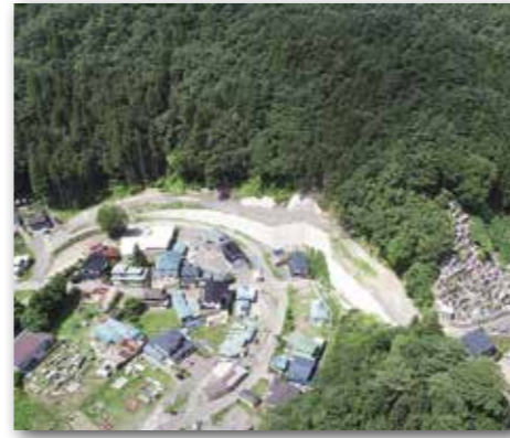
高台から県道に抜ける避難路整備（写真①）
