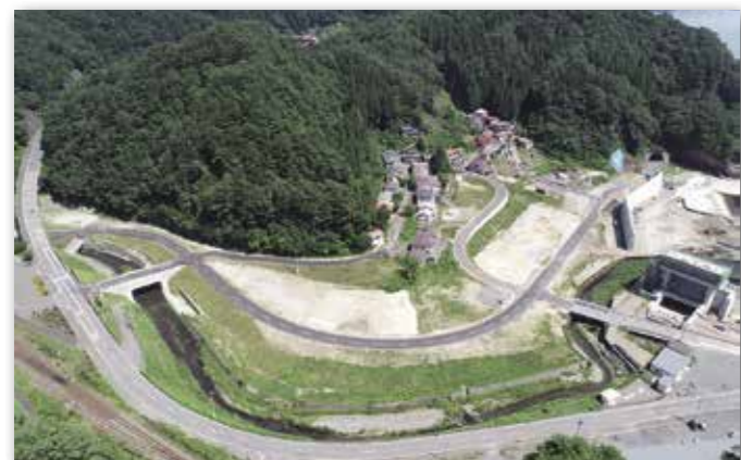
平井賀漁港周辺では集落内の道路工事が完了（写真⑤）
